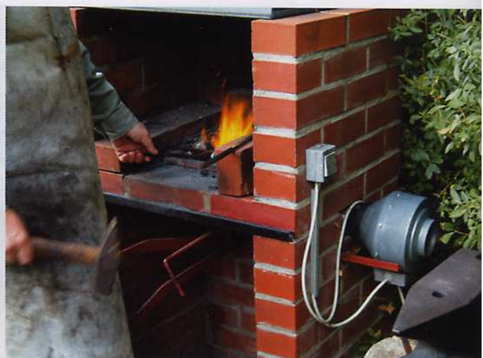
PUSTET KRÄFTIG: Die Luftzufuhr übernimmt ein elektrischer Röhrenventilator.
